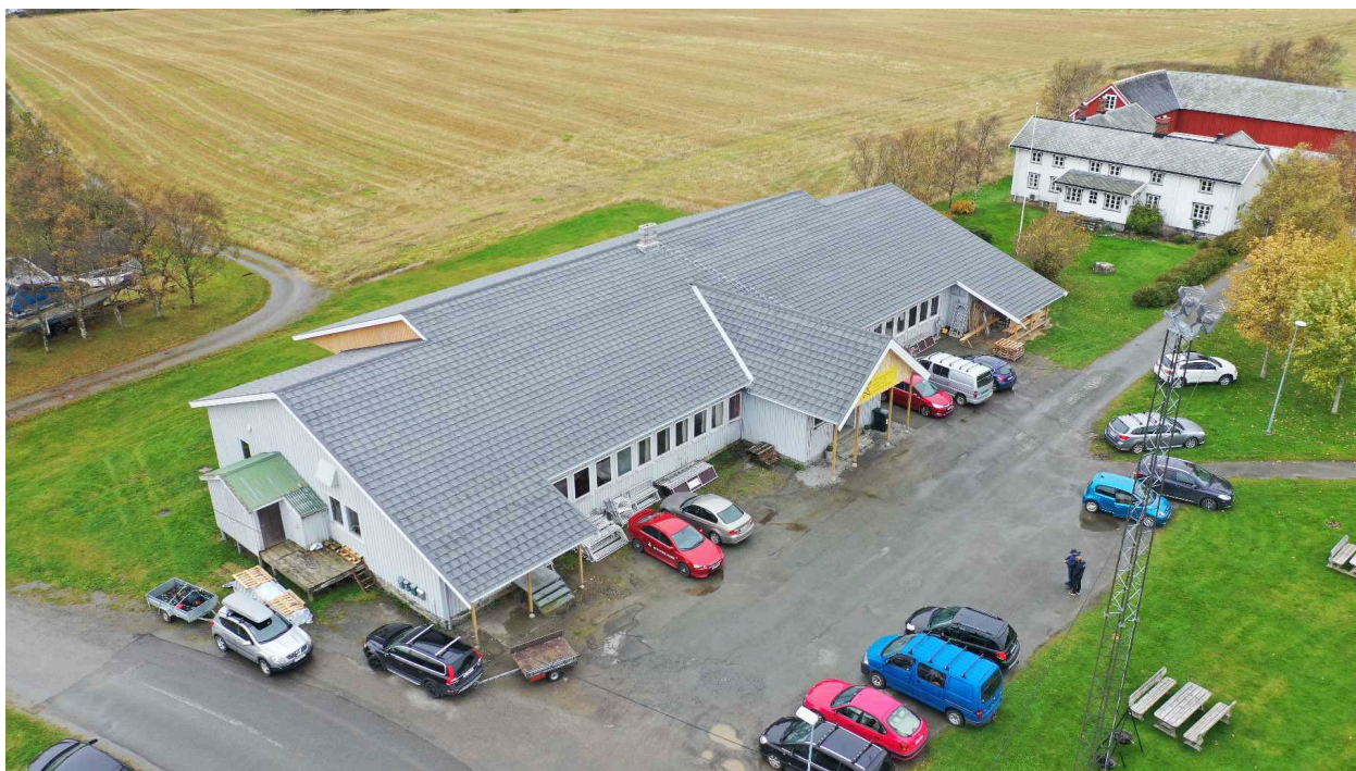
Velferdsbygget etter takutskiftingen høsten 2023.
