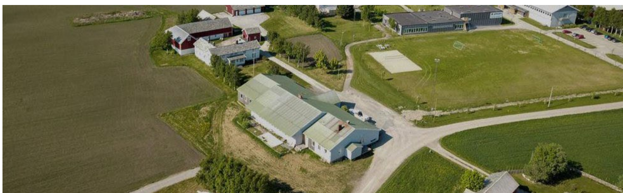
Hysnes-området i Hasselvika. Velferdsbygget nærmest, før takutskiftingen.
